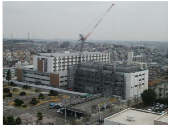
建築現場全景写真
